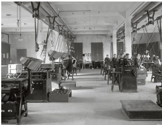
HYLSEVERKSTED: I 1896 ble fyrstikkfabrikken på Raufoss erstattet med ammunisjonslager, som Staten flyttet hit fra det mer utsatte Christiania. Her fra hylseverkstedet, rundt 1918.
